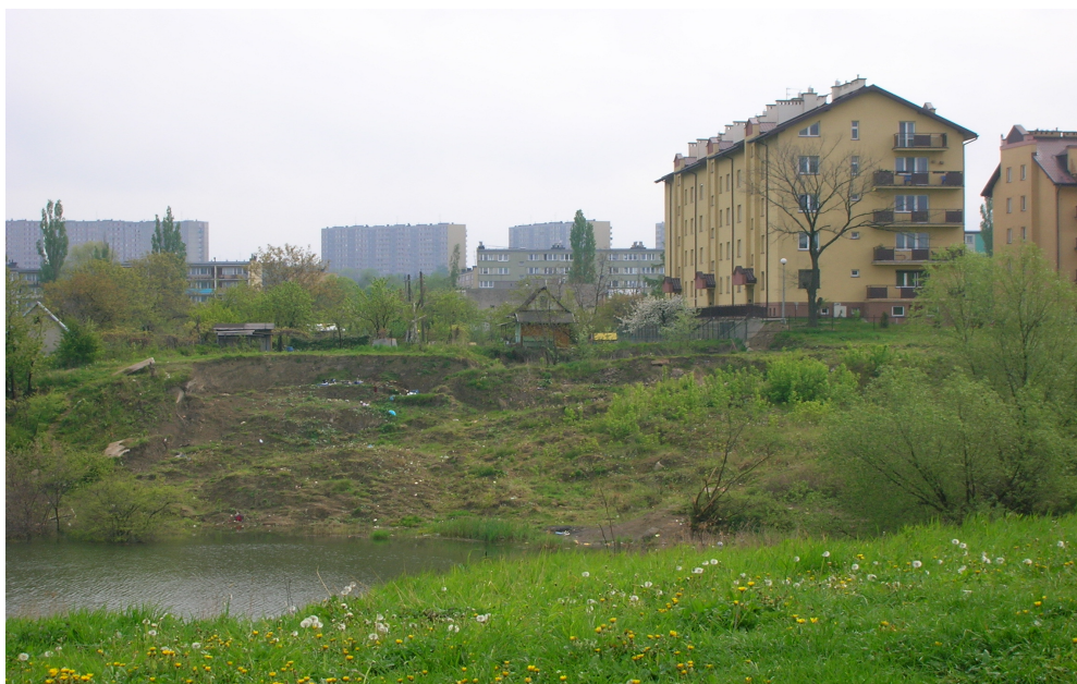
Fot. 1. Osuwisko na skarpie wyrobiska cegielni „Kantoria”. Tarnów, maj 2007 Phot. 1. Landslide on the slope of the clay pit „Kantoria”. Tarnow, May 2007
